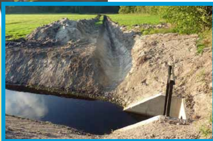
W trakcie modernizacji
